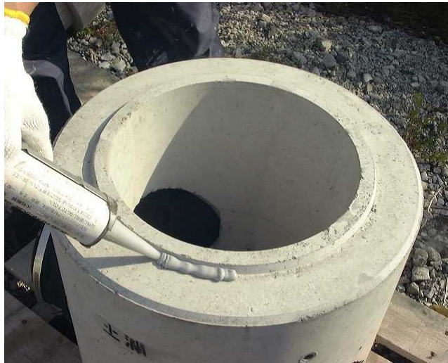
シーラントの塗布
